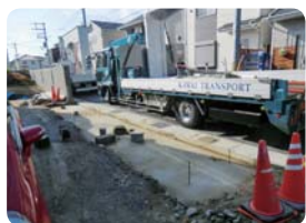
① 基礎打設 (工事店様にて) メーカーにて作図した基礎図に基づいて、基礎コンクリートの打設をお願いします。
