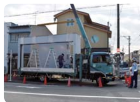
② ゲートの設置 (メーカーと工事店様にて) 4t・10t ユニック車にて設置作業となります。道路状況に応じて、道路使用許可書及び交通整備の方をご準備下さい。
