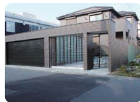
⑥ 仕上げ施工 (工場店様にて) 様々な仕上げ施工をさせていただき完成となります。
