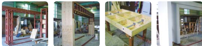
耐震性を考慮した鉄骨構造 (FIT-GATE) メーカー基準の構造計算書に基づき鉄骨構造下地。
