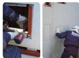
③ 連棟型ゲートの場合 (メーカーにて) 連棟型躯体をドッキングさせる場合はメーカーにて躯体と躯体をボルトにてドッキングします。
